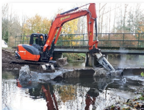
Arasement du seuil en «V» de Doureux
