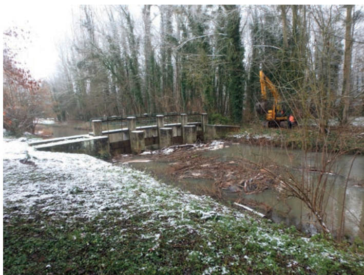
Ouvrage hydraulique à supprimer
