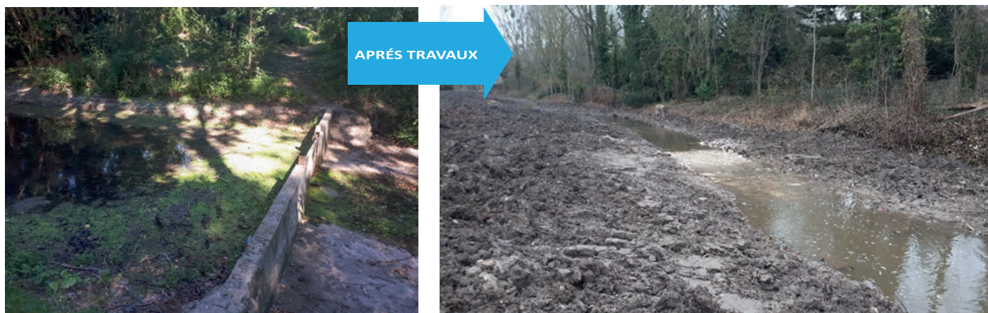
Ouvrage du bourg d'Escrennes avant et après effacement
