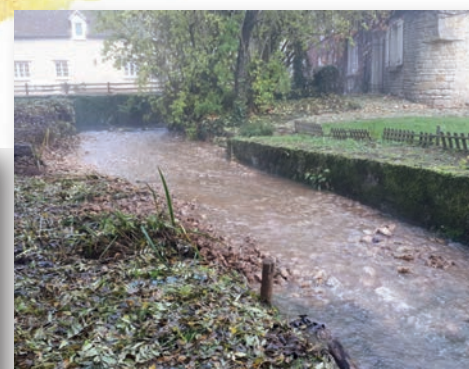
Bras de décharge du Moulin de Doureux rendu franchissable
