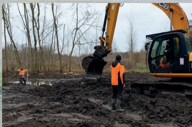
Suivi de chantiers
