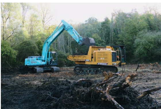
Exportation du broyat pour éviter l'enrichissement du milieu
